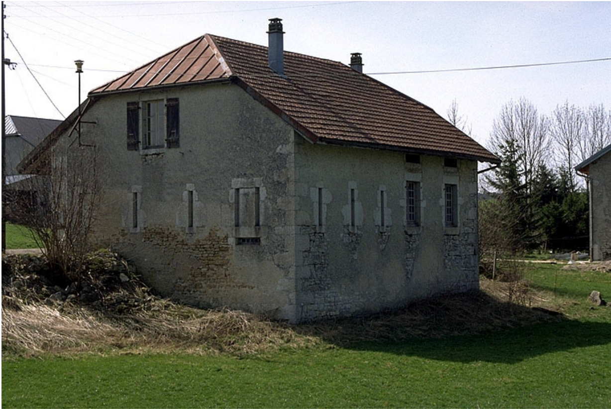
Façades postérieure et latérale gauche.
