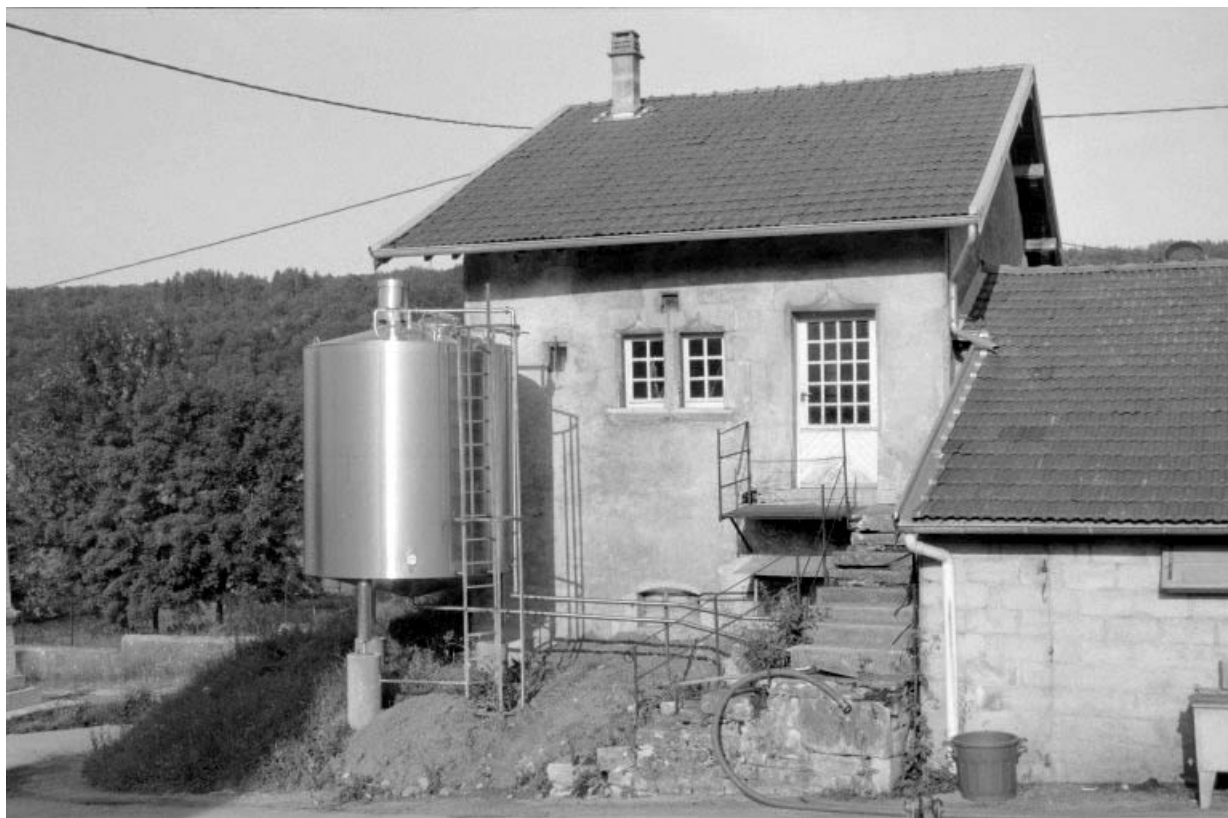
Façade postérieure de la maison.
