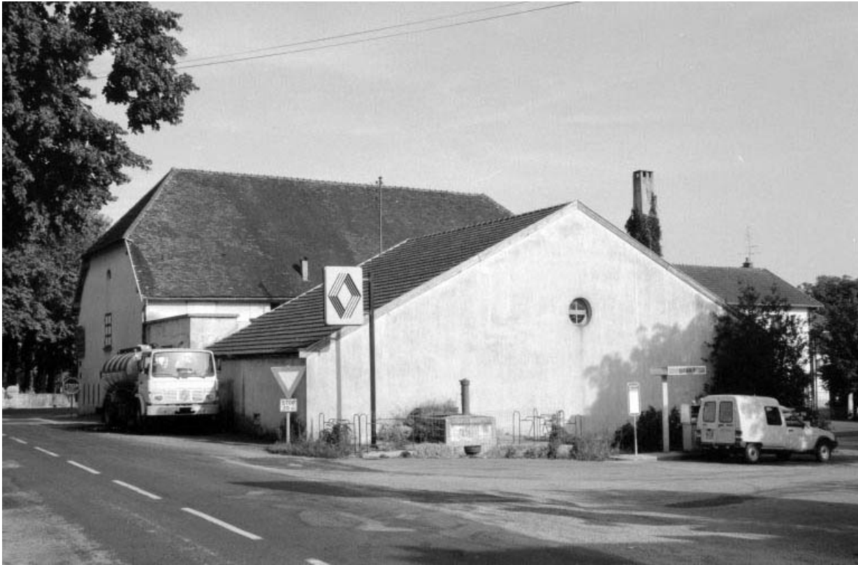
Fromagerie et pièce d'affinage vues du nord-ouest.
