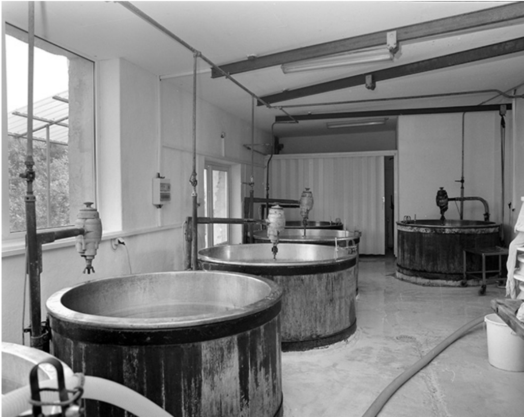
Intérieur de l'atelier de fabrication. 39, Arthenas
