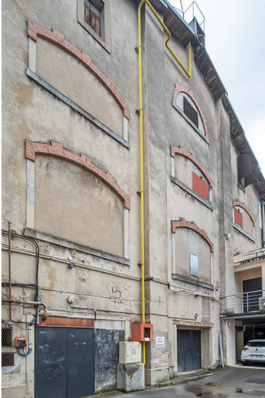
Halle : façade postérieure depuis la cour.
