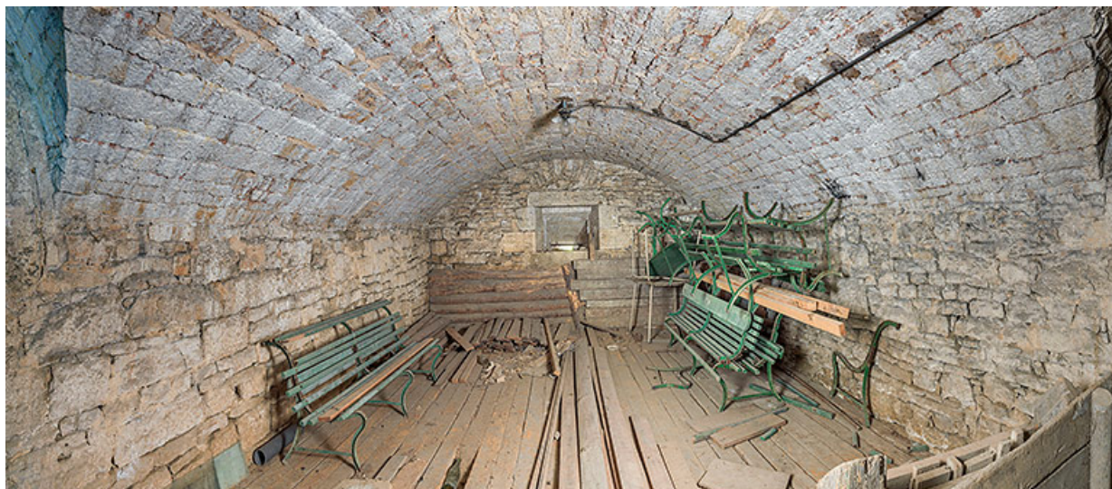
Vue générale d'une casemate.
