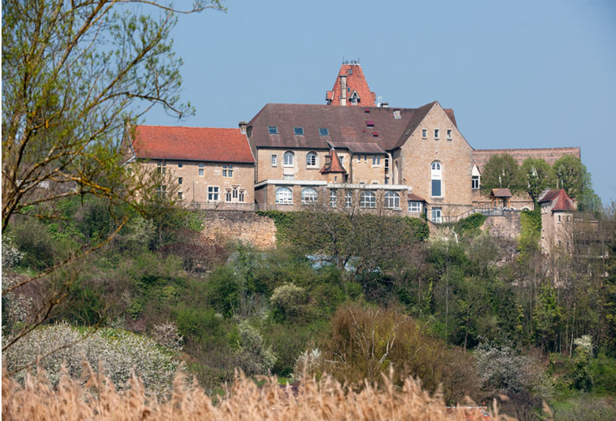
Vue d'ensemble rapprochée.
