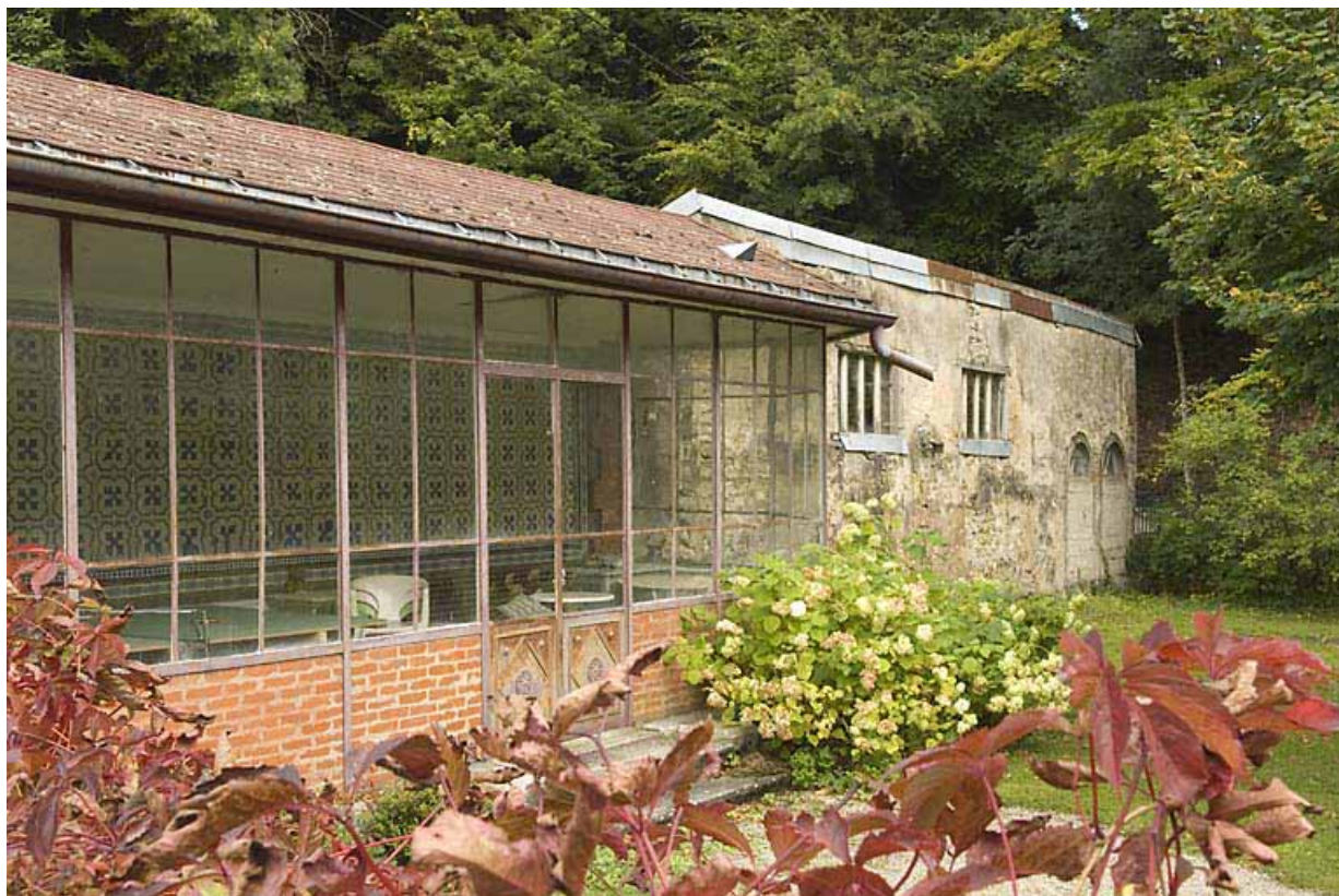
Serre et garage, vus de trois quarts.
