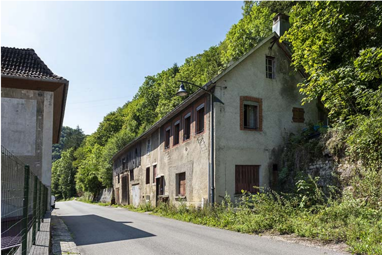
Logement occidental : vue d'ensemble, depuis le nord.
