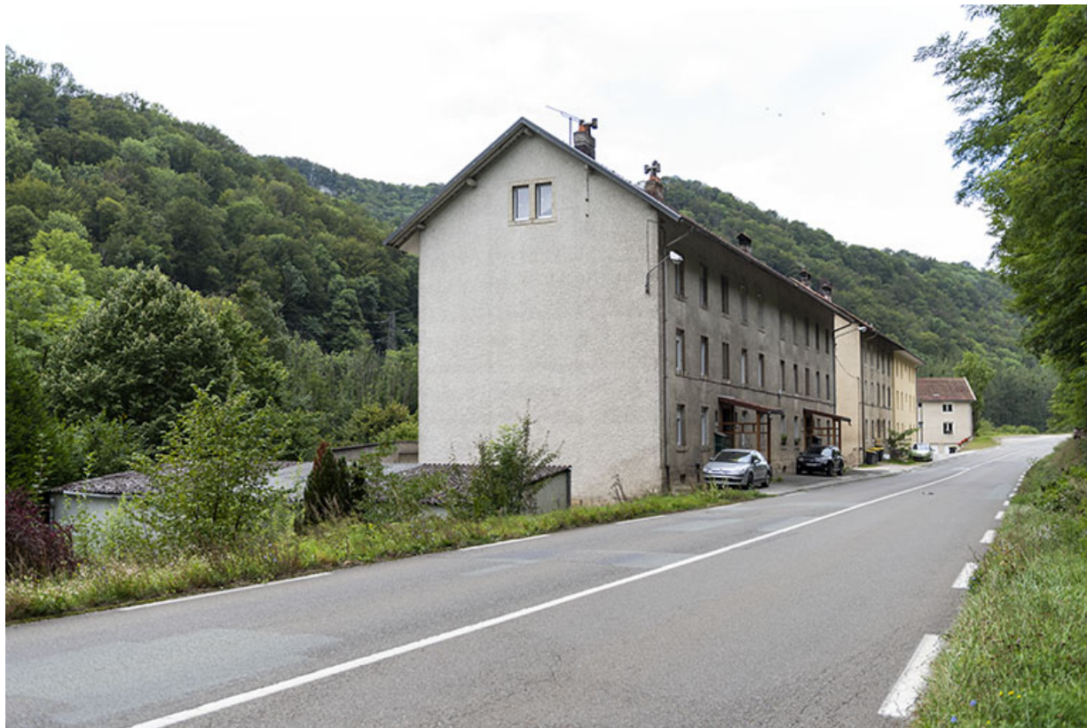
Vue d'ensemble, depuis la route à l'est.
