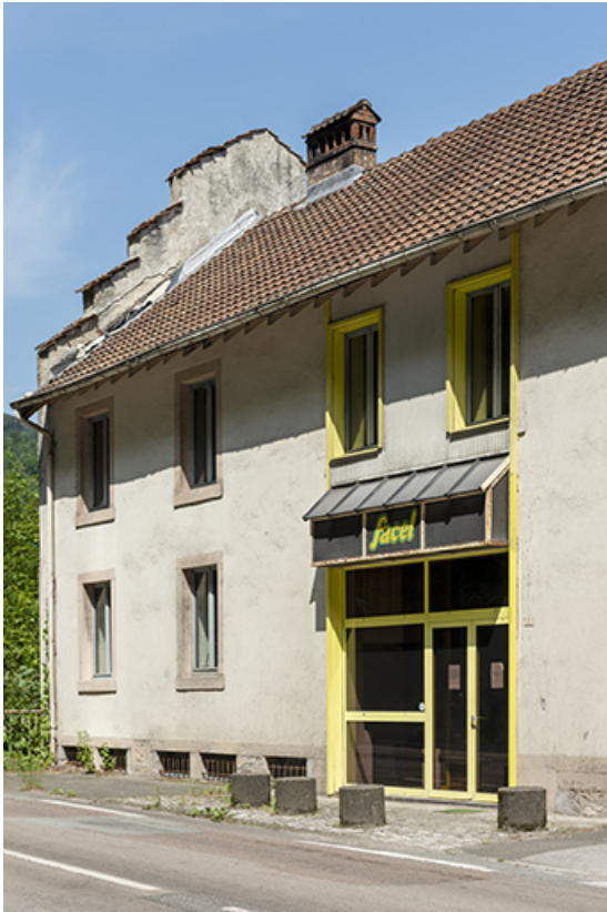
Bureau, façade antérieure : entrée.
