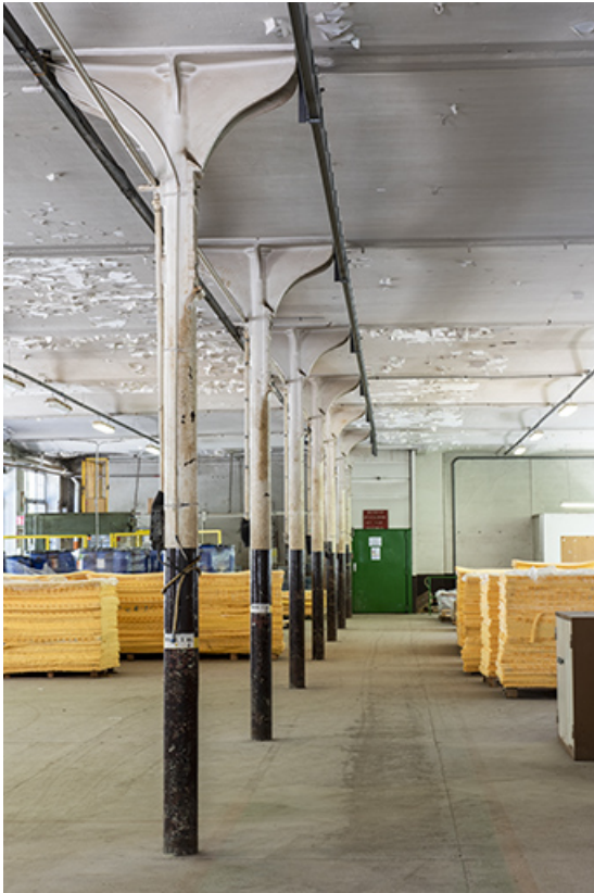
Atelier de fabrication (ancienne tréfilerie, 1er étage) : poteaux en fonte et voûtaines en briques plâtrées. 25, Liebvillers rue des Forges, lieudit : le Gouffre du Lods
