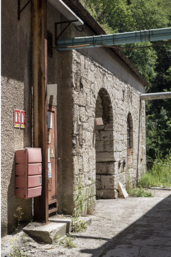
Bâtiment d'eau : façade antérieure, vue en enfilade.
