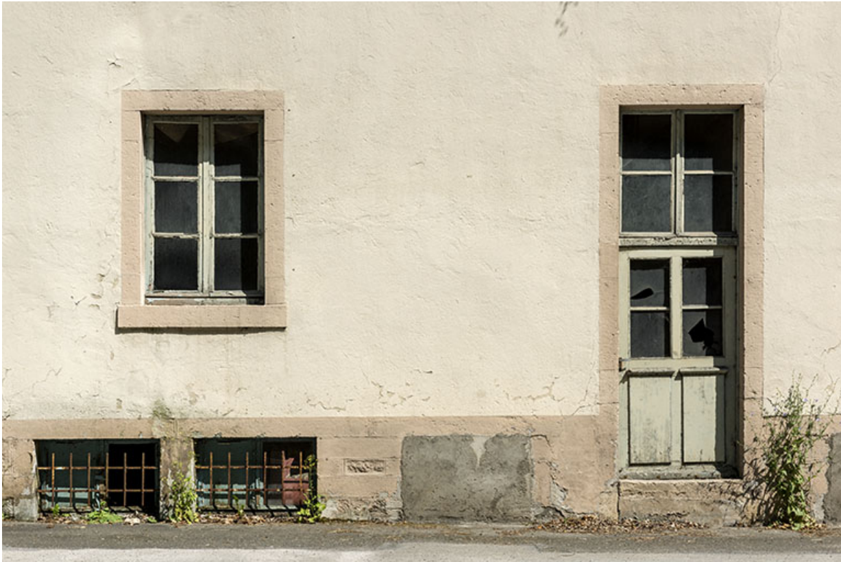
Bureau, façade antérieure : détail.
