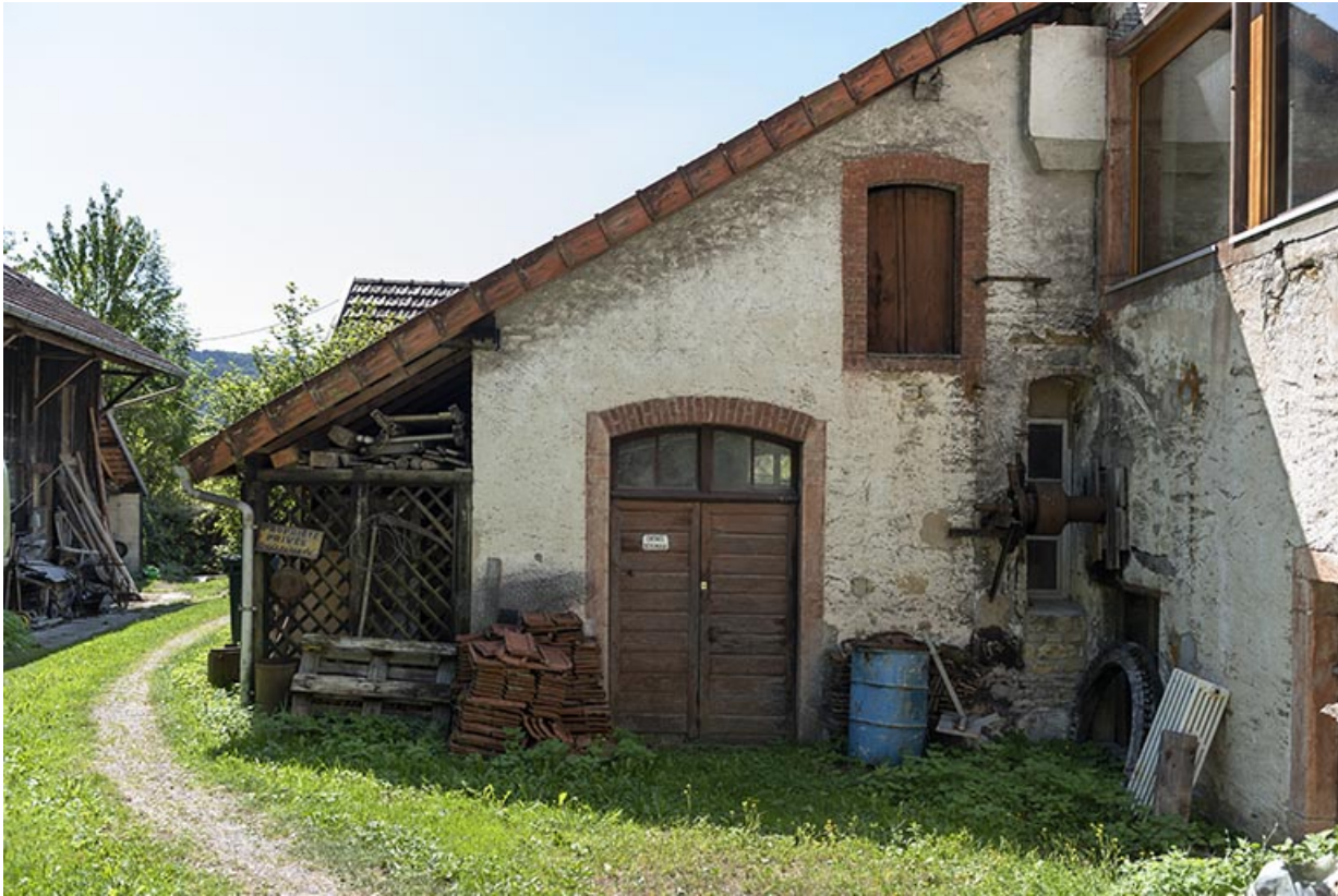
Bâtiment d'eau : façade antérieure.
