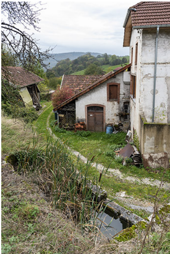
Bâtiment d'eau, vu de l'est.
