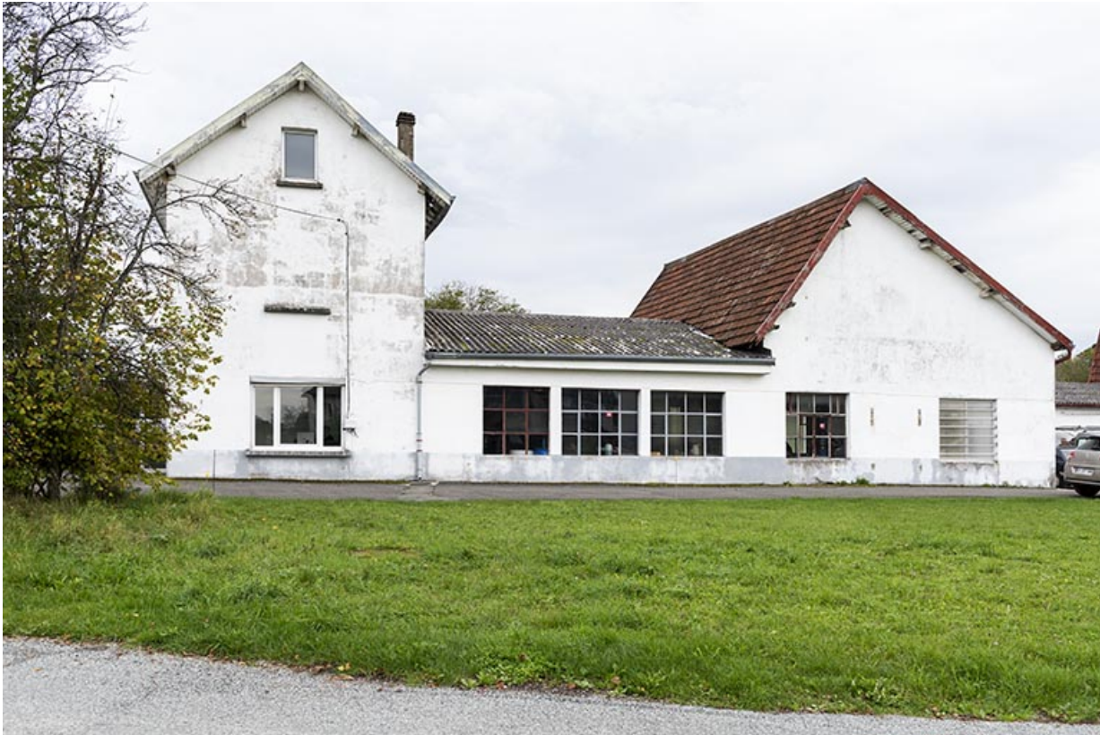
Bâtiments nord : façade latérale droite.
