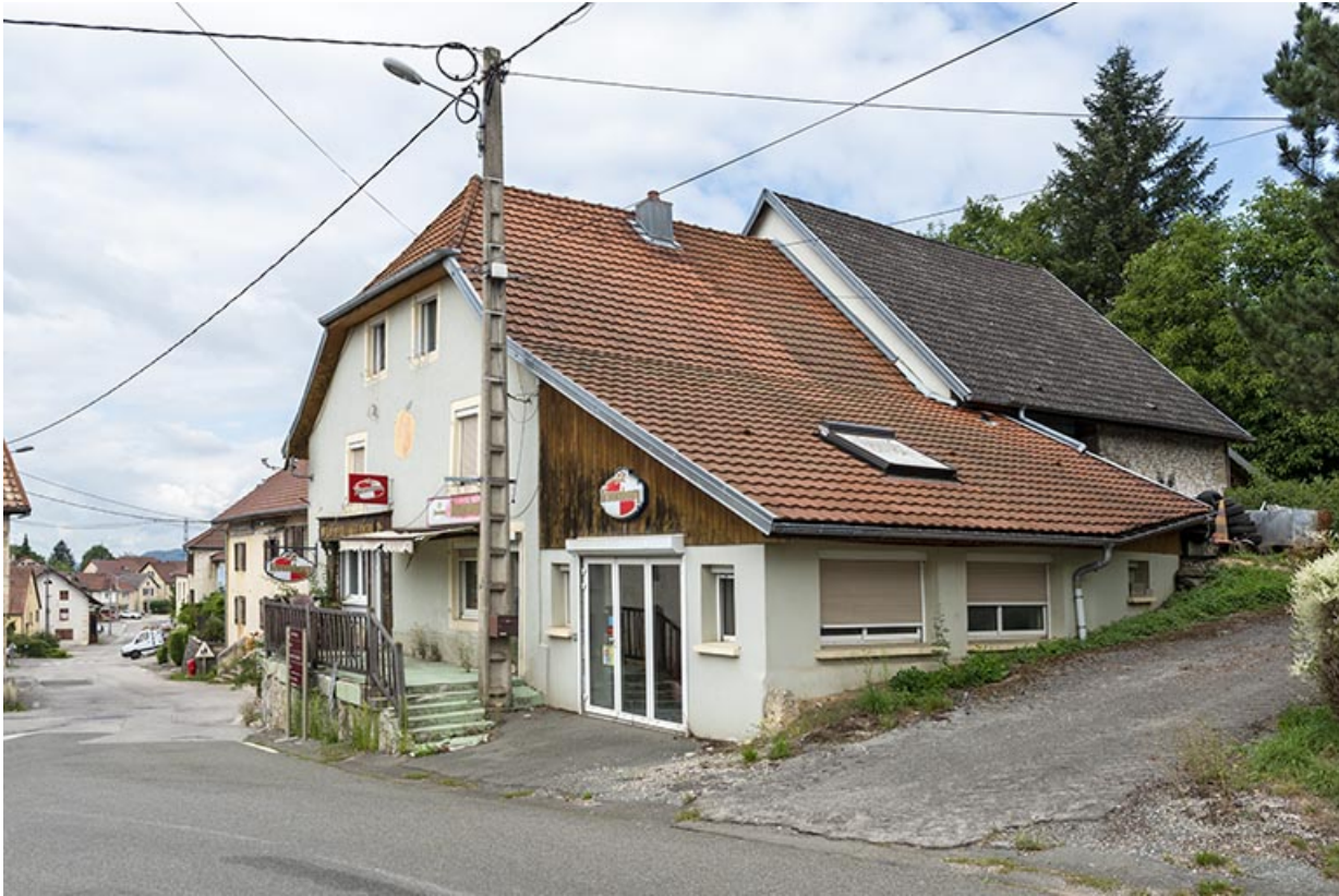
Façades antérieure et latérale droite.
