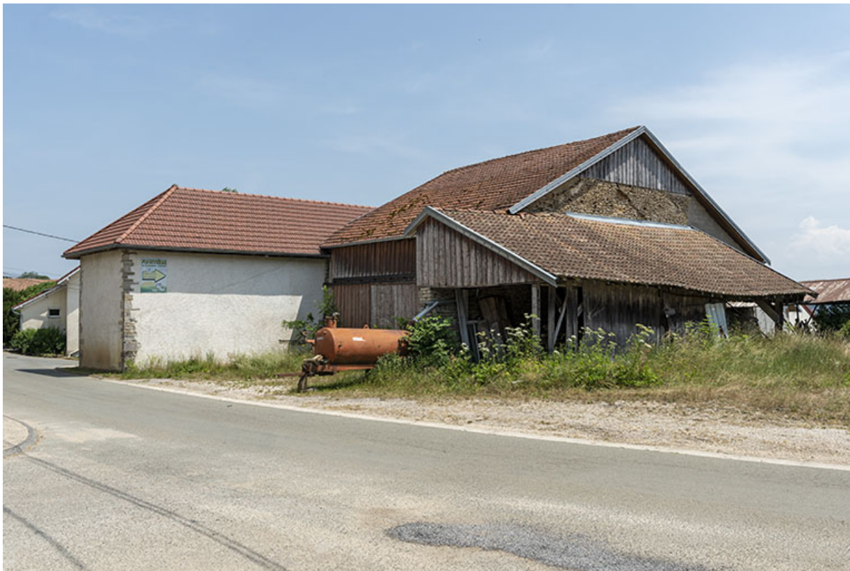
Cave d'affinage (façade postérieure), grange et hangar.
