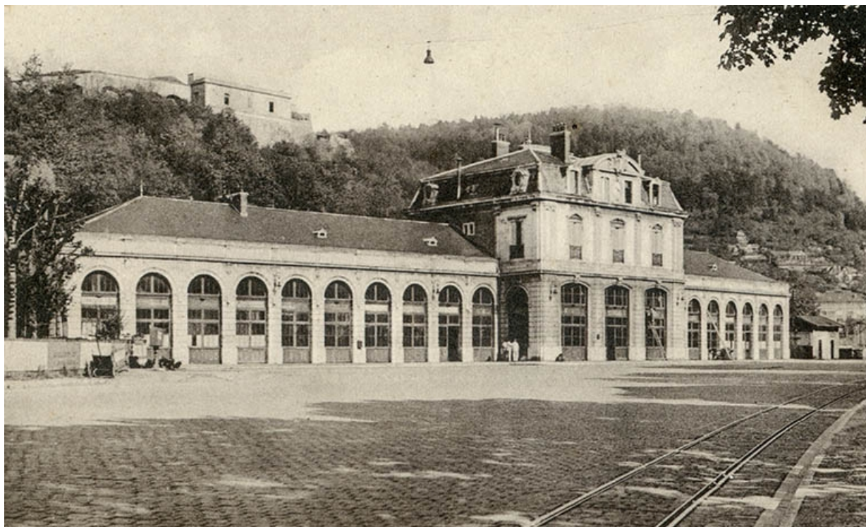
Vue ancienne, façade côté rue.
