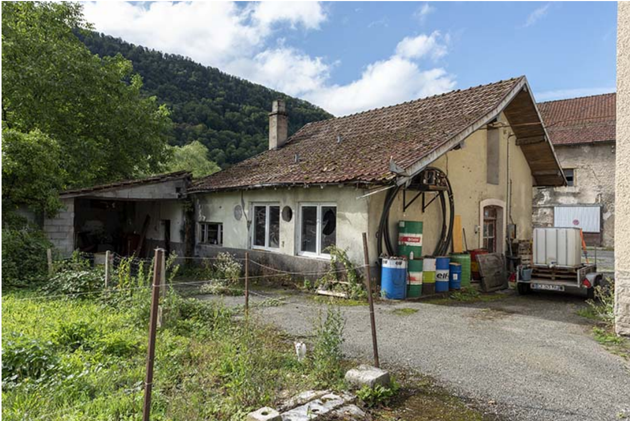
Façades antérieure et latérale gauche.
