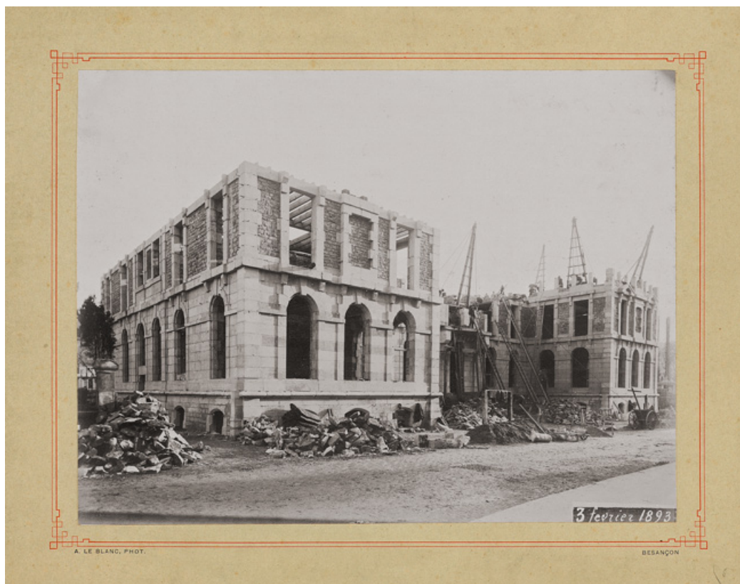
Chantier de construction (3 février 1893).
