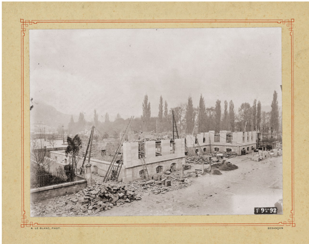
Chantier de construction (1er novembre 1892).
