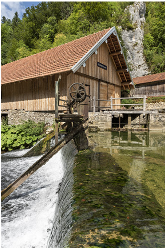
Barrage et vannes, depuis la rive gauche.
