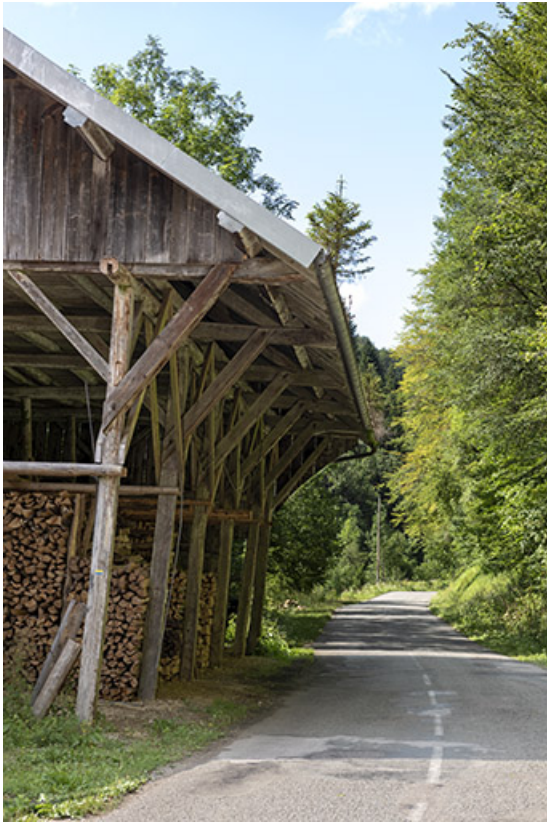
Hangar, depuis le sud.
