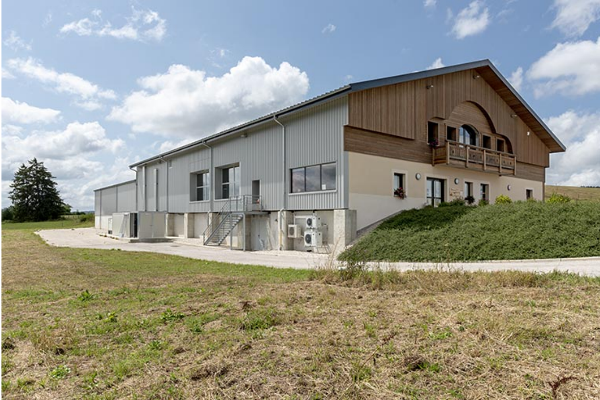
Façades antérieure et latérale gauche.
