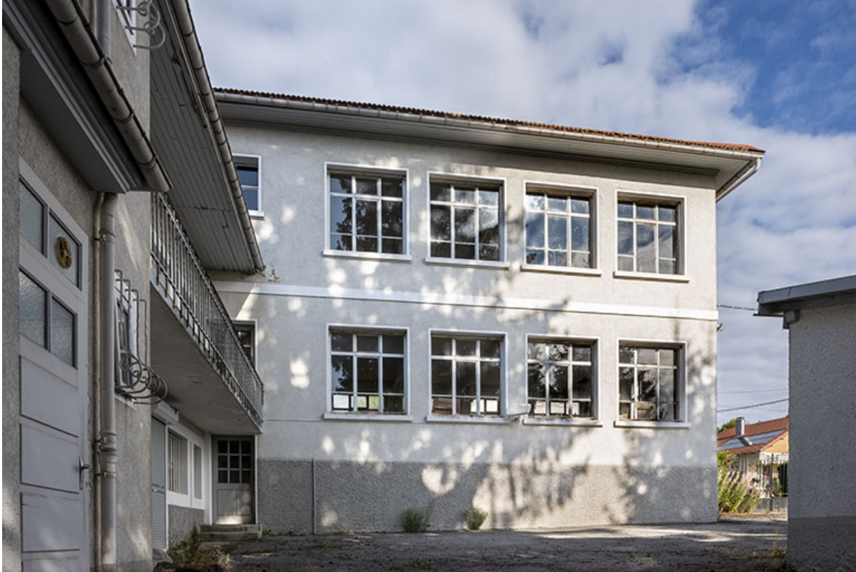
Atelier de 1930 : façade postérieure (est).
