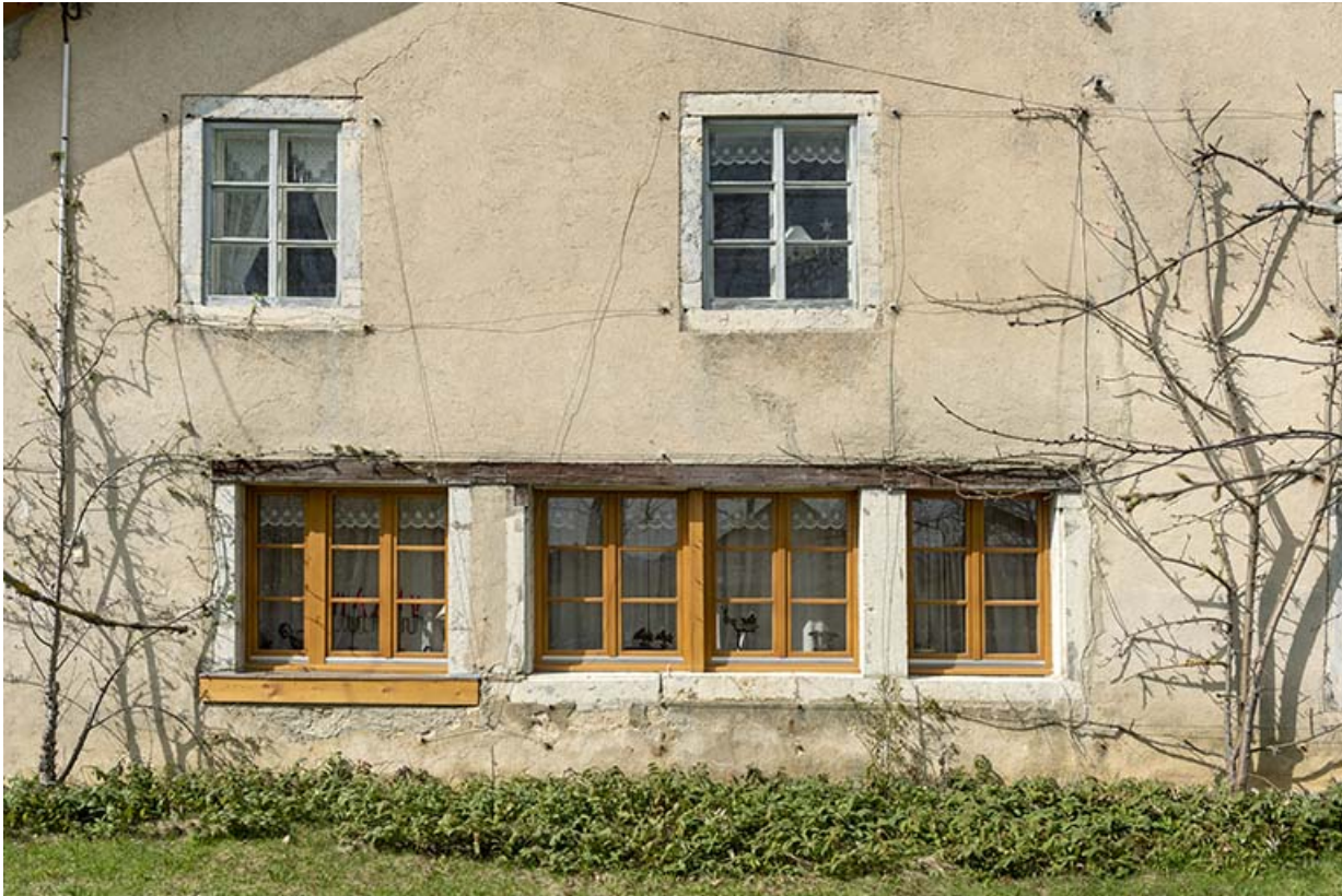
Façade sud : fenêtre multiple de l'atelier.
