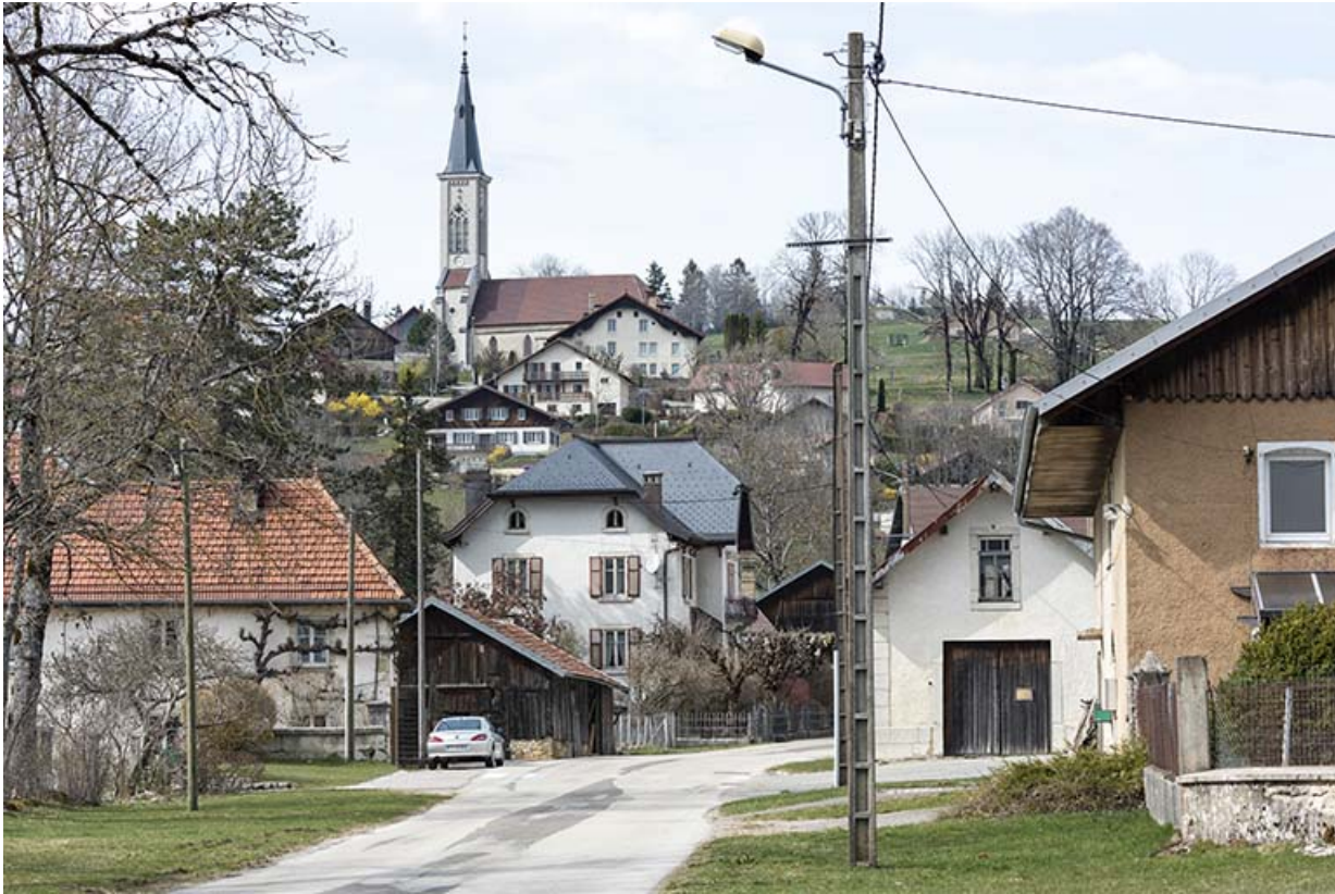
Vue d'ensemble éloignée, depuis le sud.
