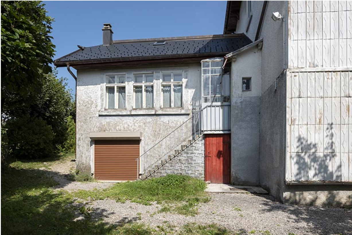
Façade postérieure de l'atelier.
