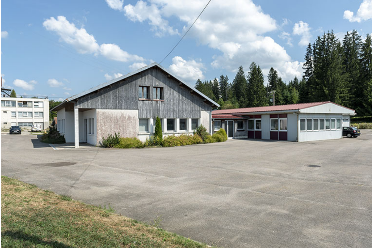
Façade latérale droite, de trois quarts gauche.
