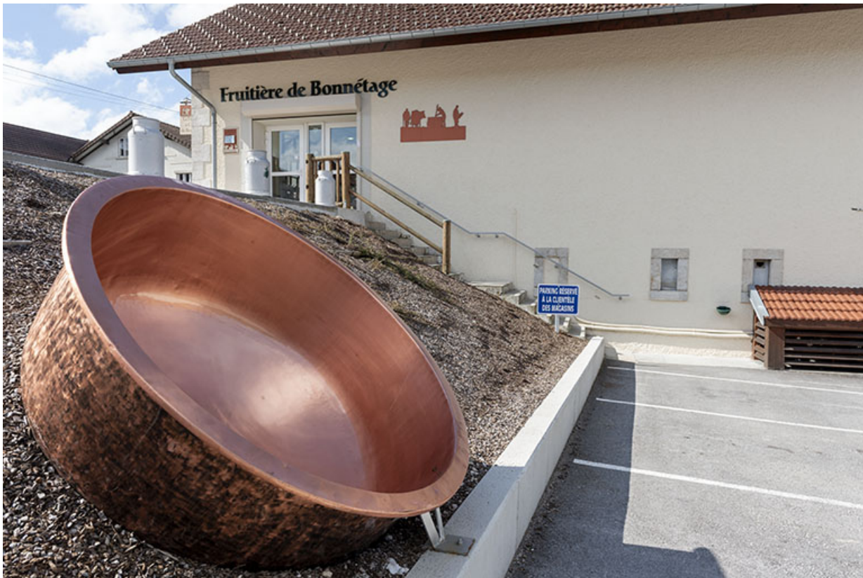
façade latérale droite et cuve.
