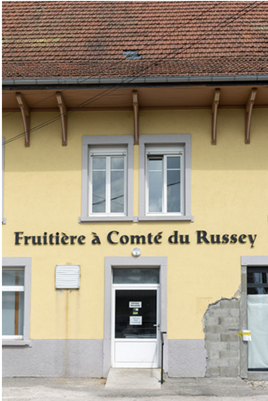
Façade antérieure : travée centrale.
