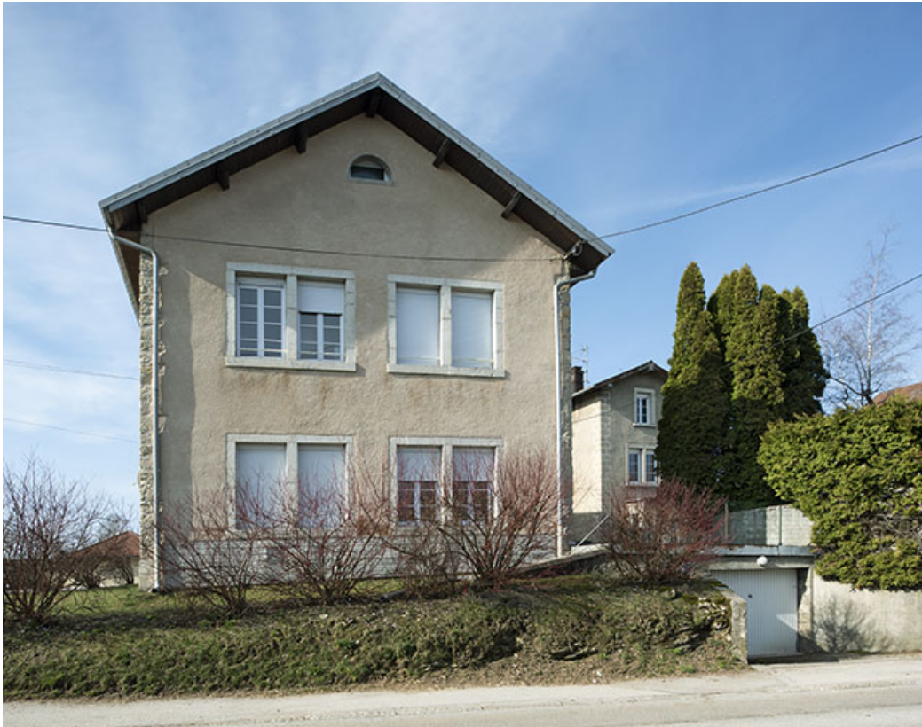
Atelier de fabrication : façade nord.
