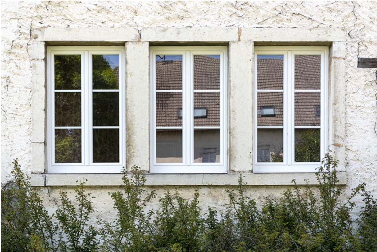
Façade latérale droite : fenêtres multiples.
