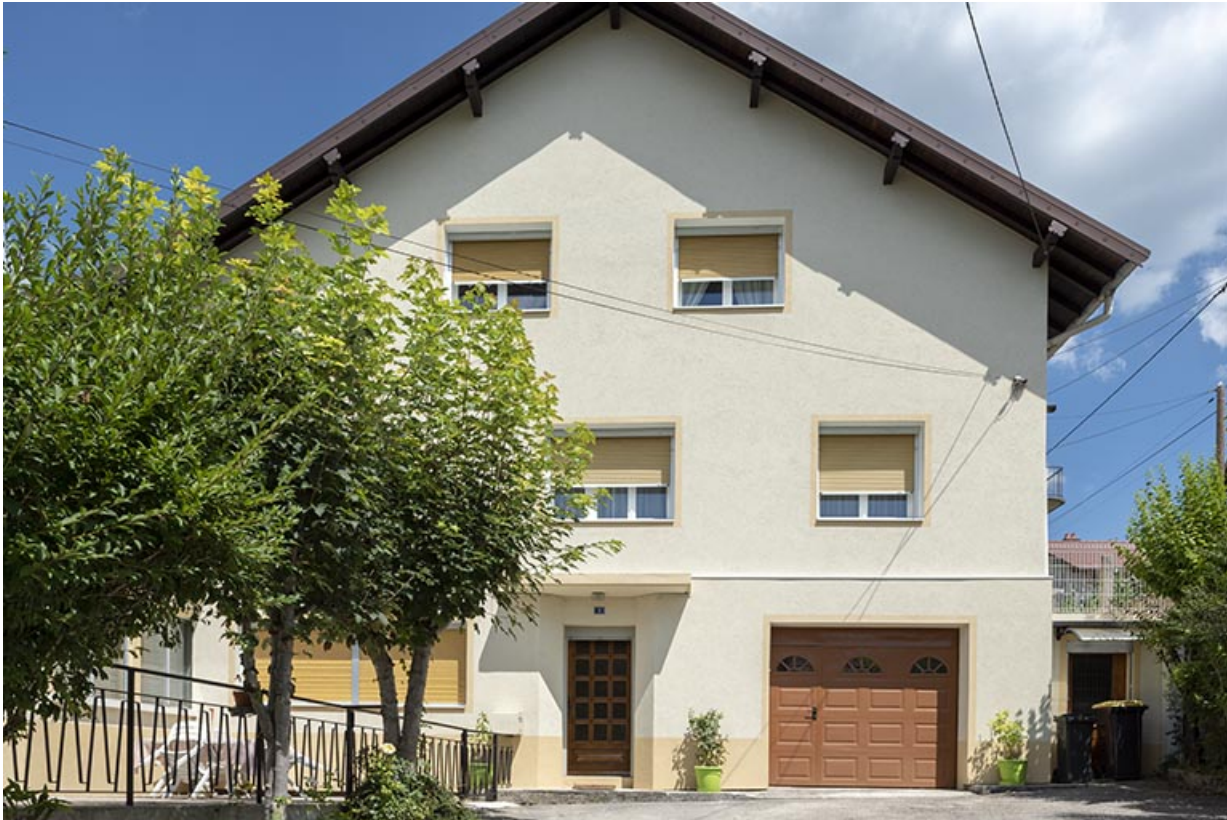
Maison : façade antérieure.
