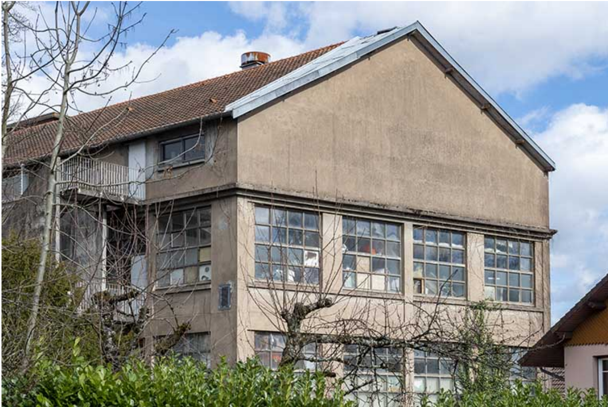
Pignon sud de l'entrepôt industriel.
