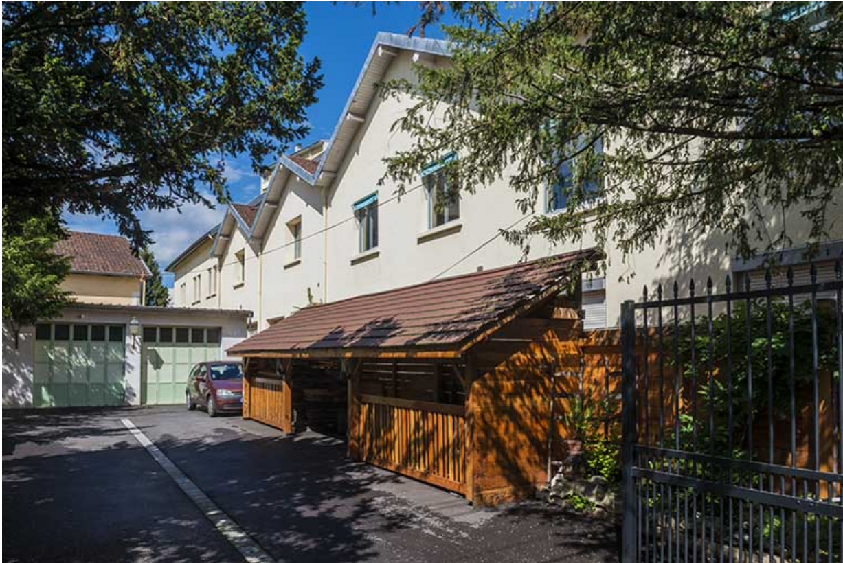
Pignons des ateliers sur la cour.
