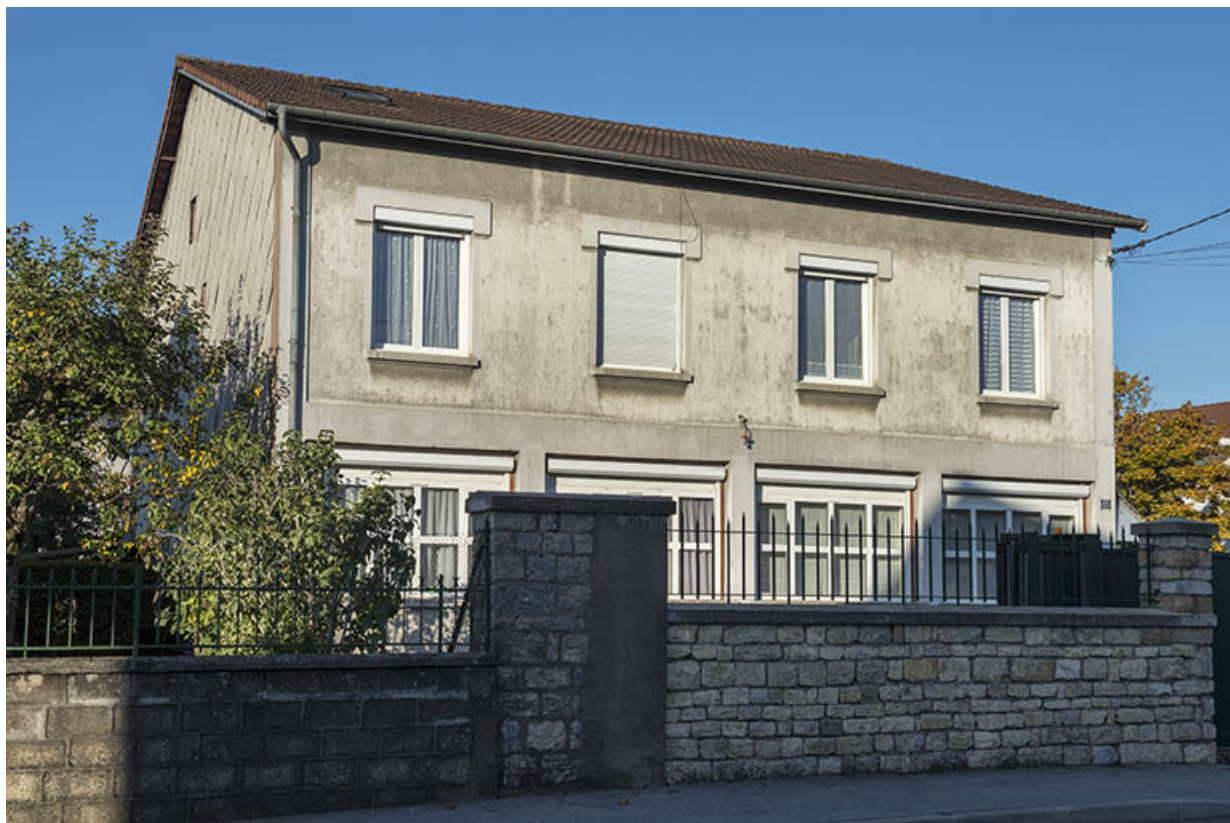
Façade est de l'atelier.
