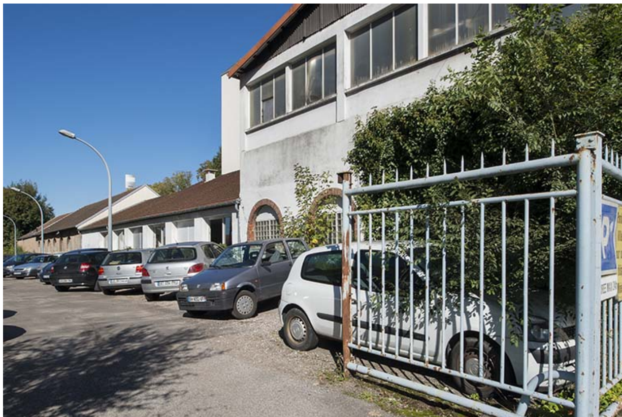
Ateliers de la fonderie. Façades ouest.
