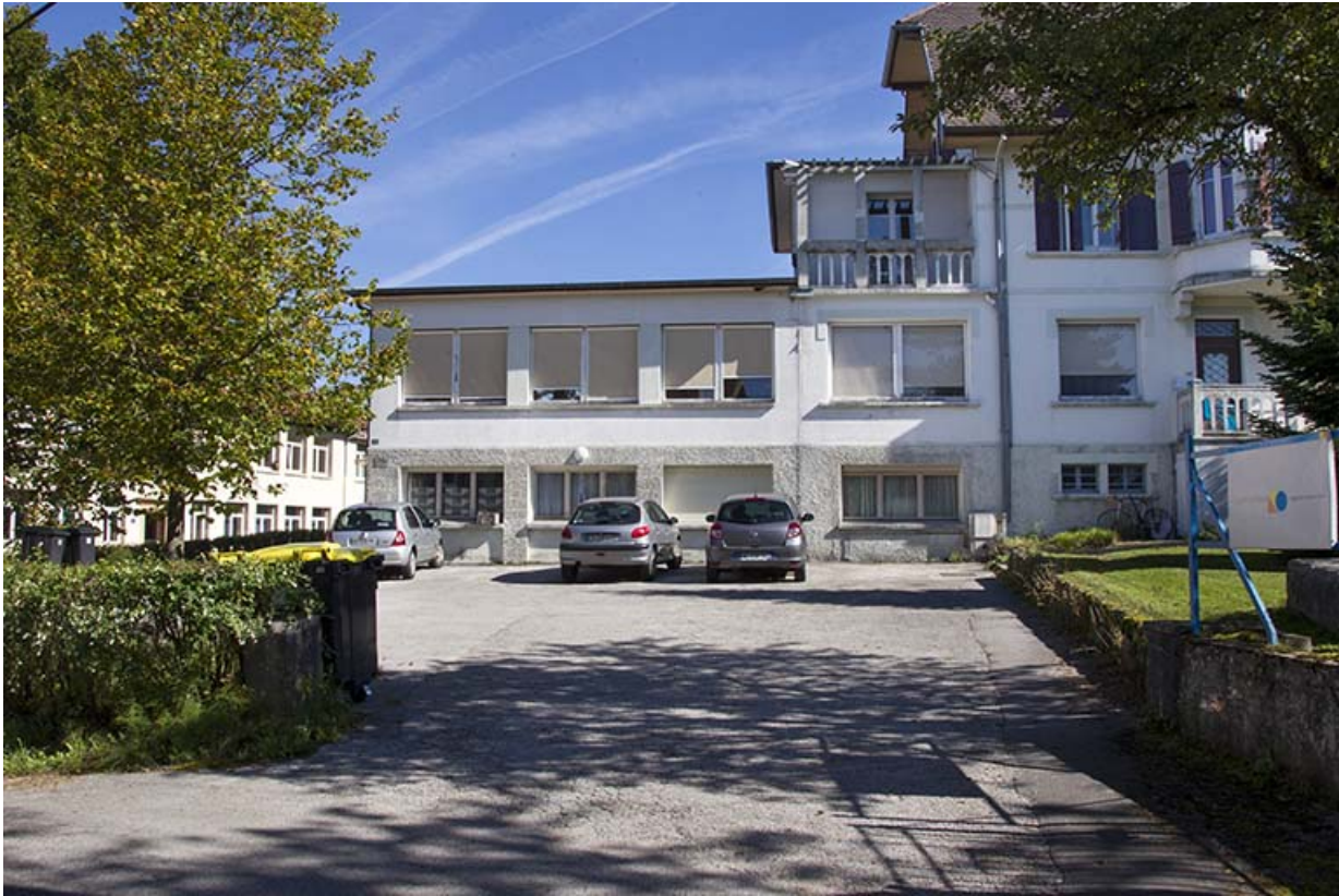
Usine : façade antérieure.
