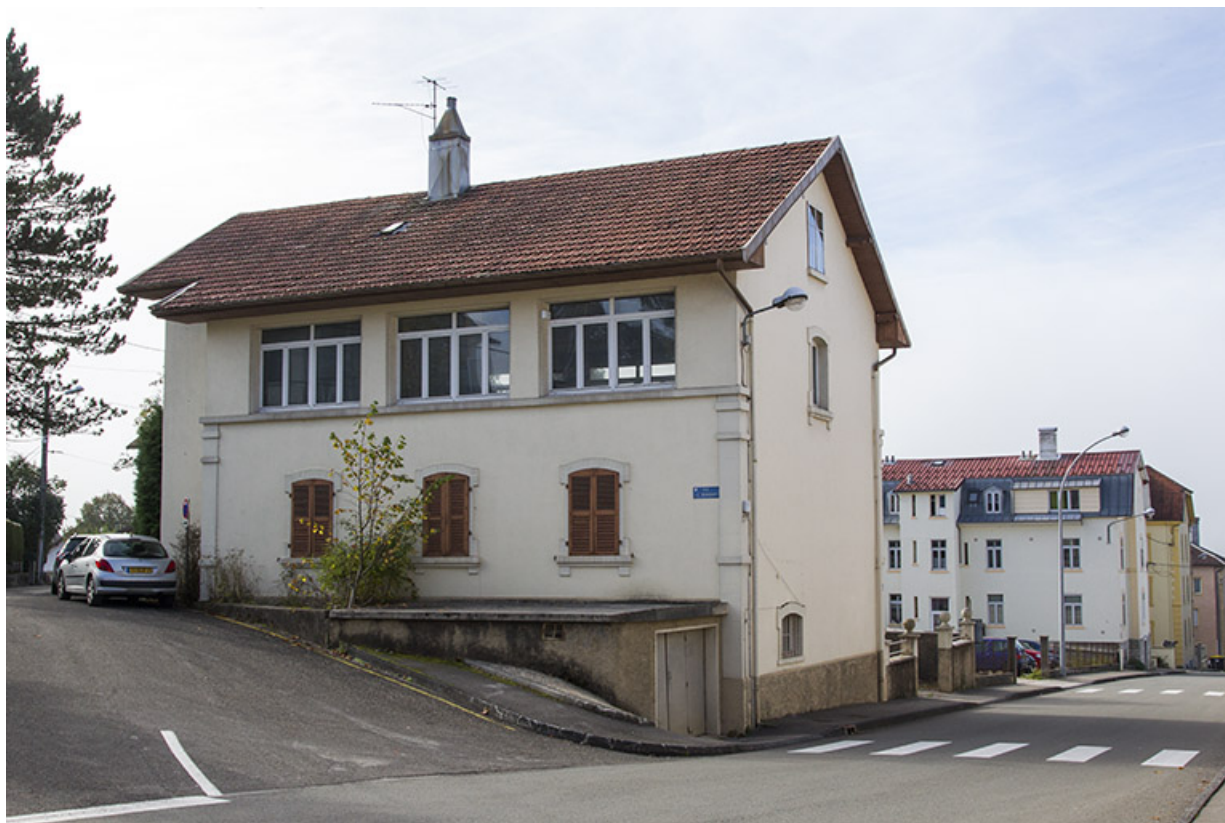
Façades postérieure et latérale gauche.
