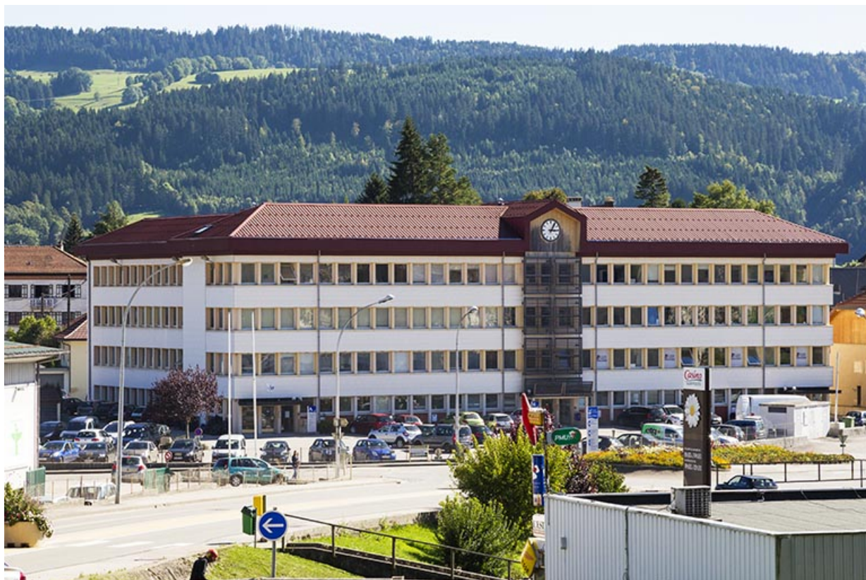
Usine : façades antérieure et latérale gauche.
