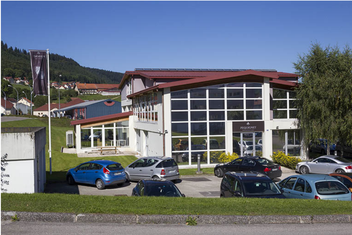
Vue d'ensemble, depuis le sud (façade antérieure).
