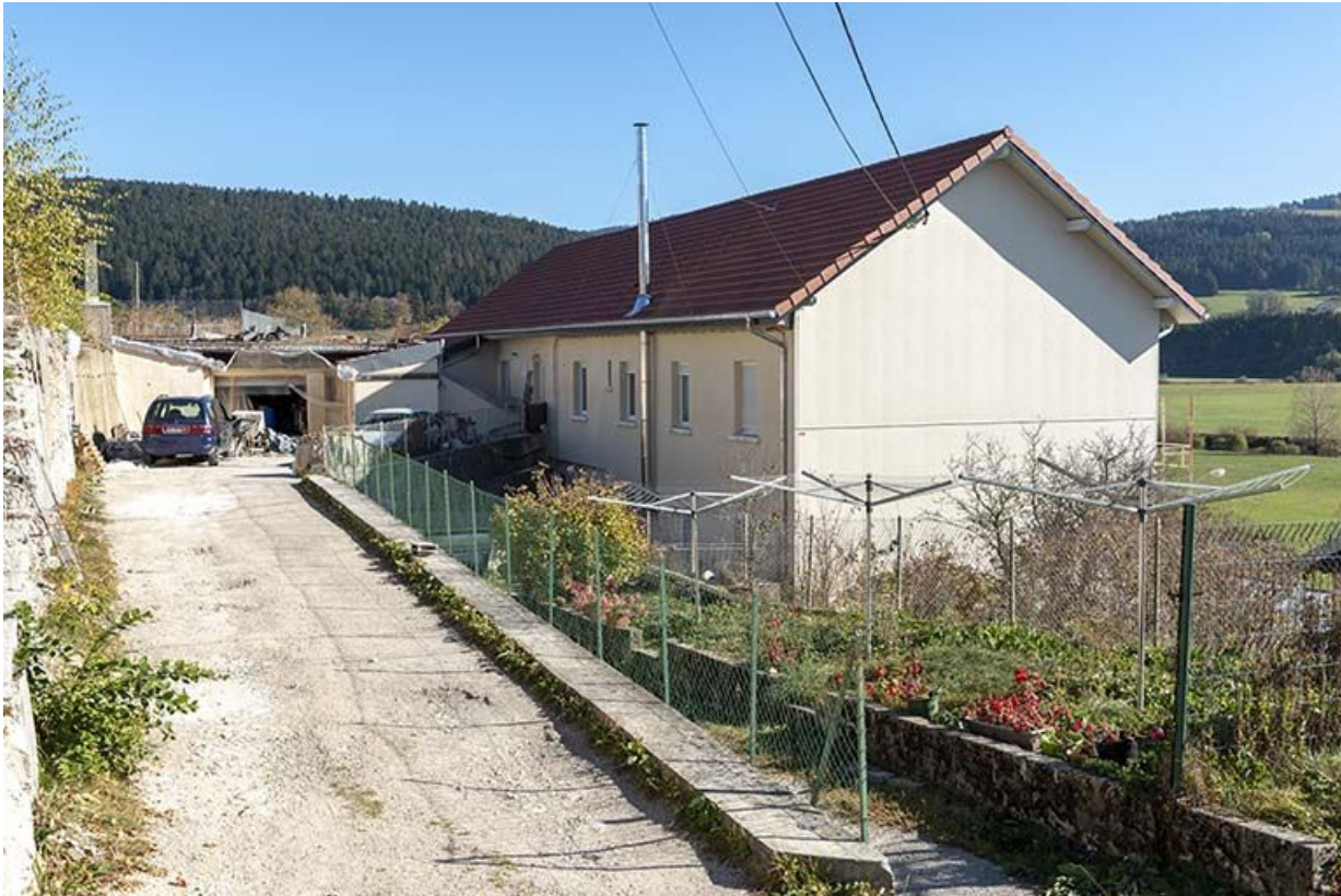
Façades sur la rue du Mondey.
