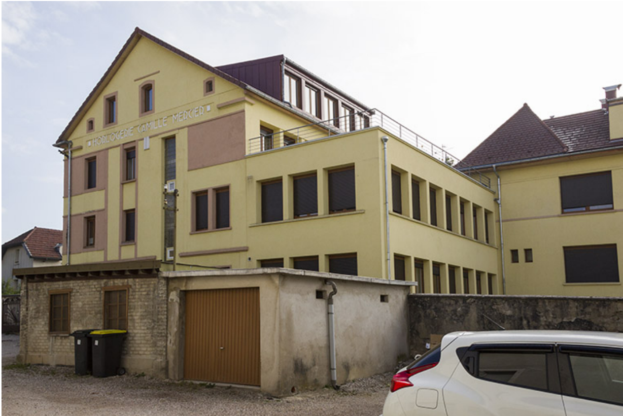
Immeuble et extension, depuis le sud-ouest.
