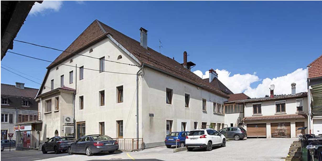
Maison : façades latérale droite et postérieure.
