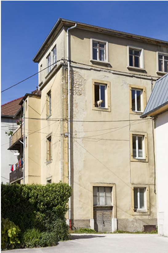
Façades latérale gauche et postérieure.
