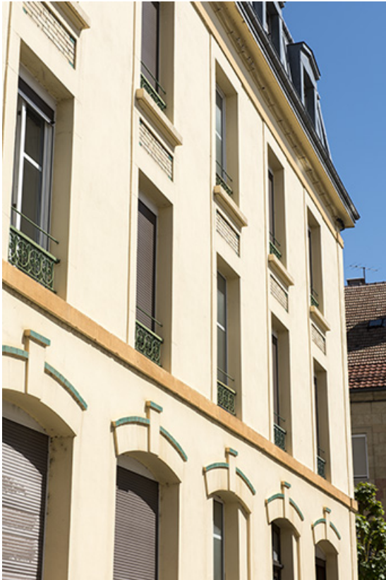
Façade latérale gauche : détail des baies.
