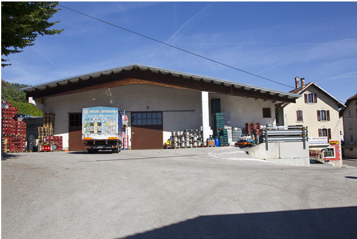
Grand entrepôt, depuis le sud.
