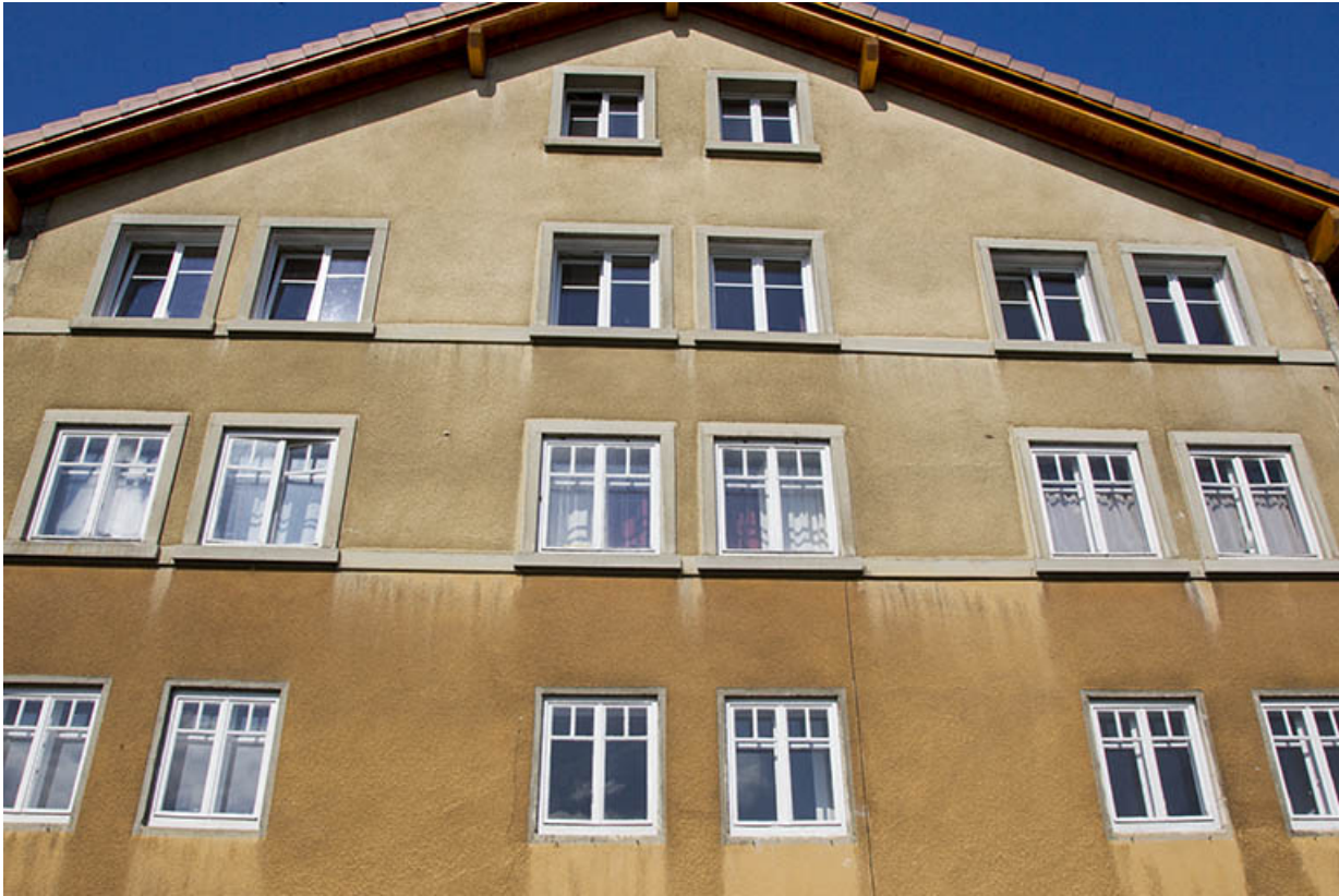
Façade postérieure, vue en contre-plongée.
