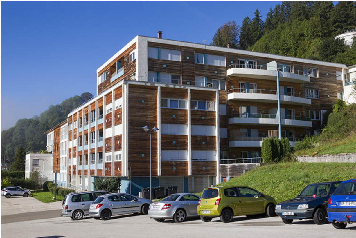
Façades antérieure et latérale droite.
