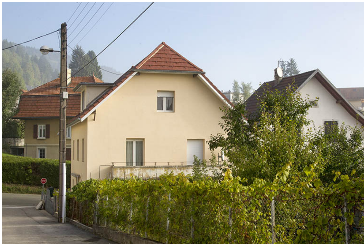
Façade latérale droite.
