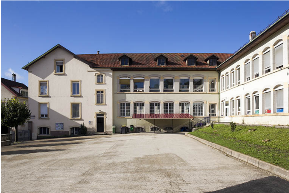
Aile ouest : façade orientale (sur cour).
