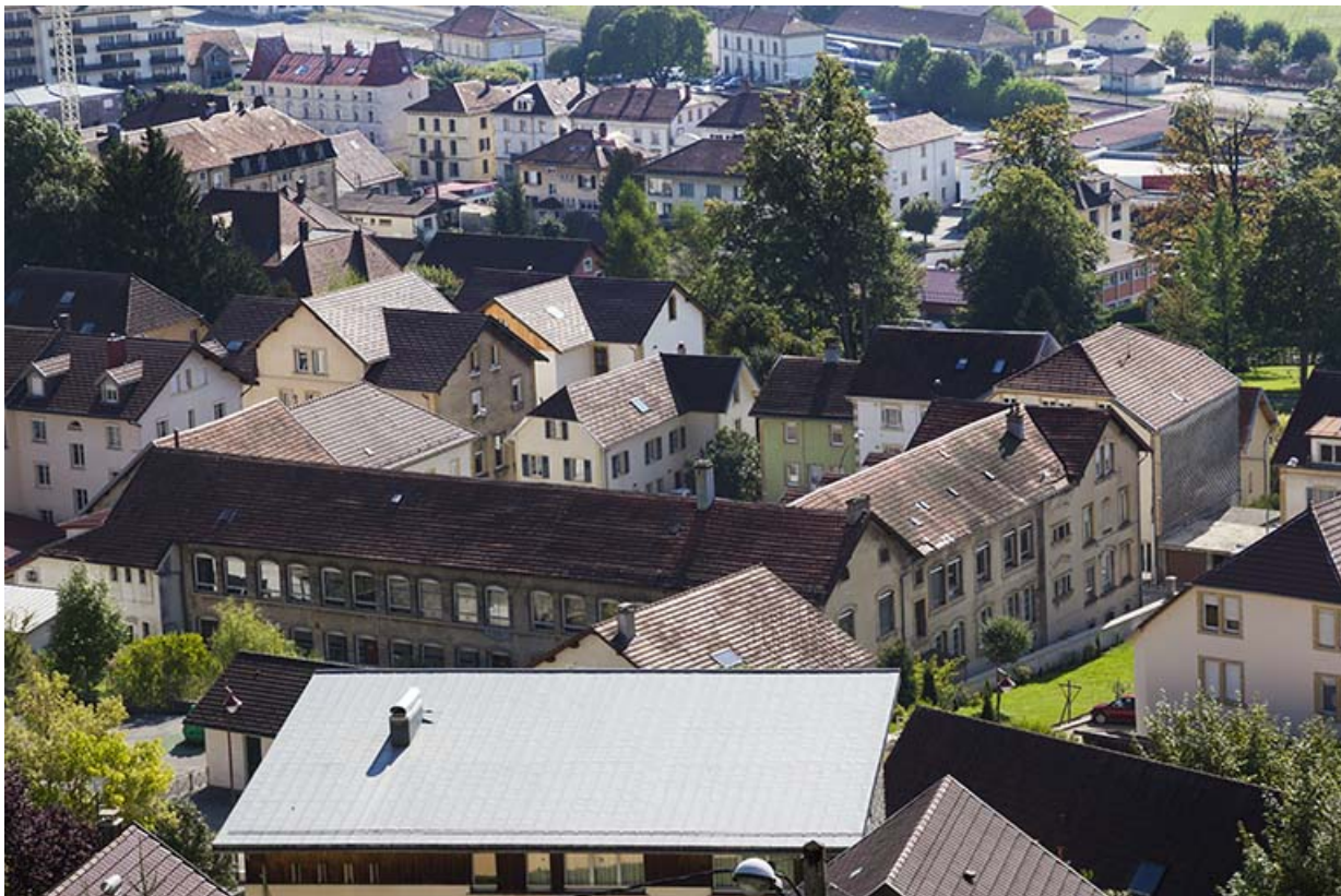
Vue d'ensemble plongeante, depuis le nord-ouest.
