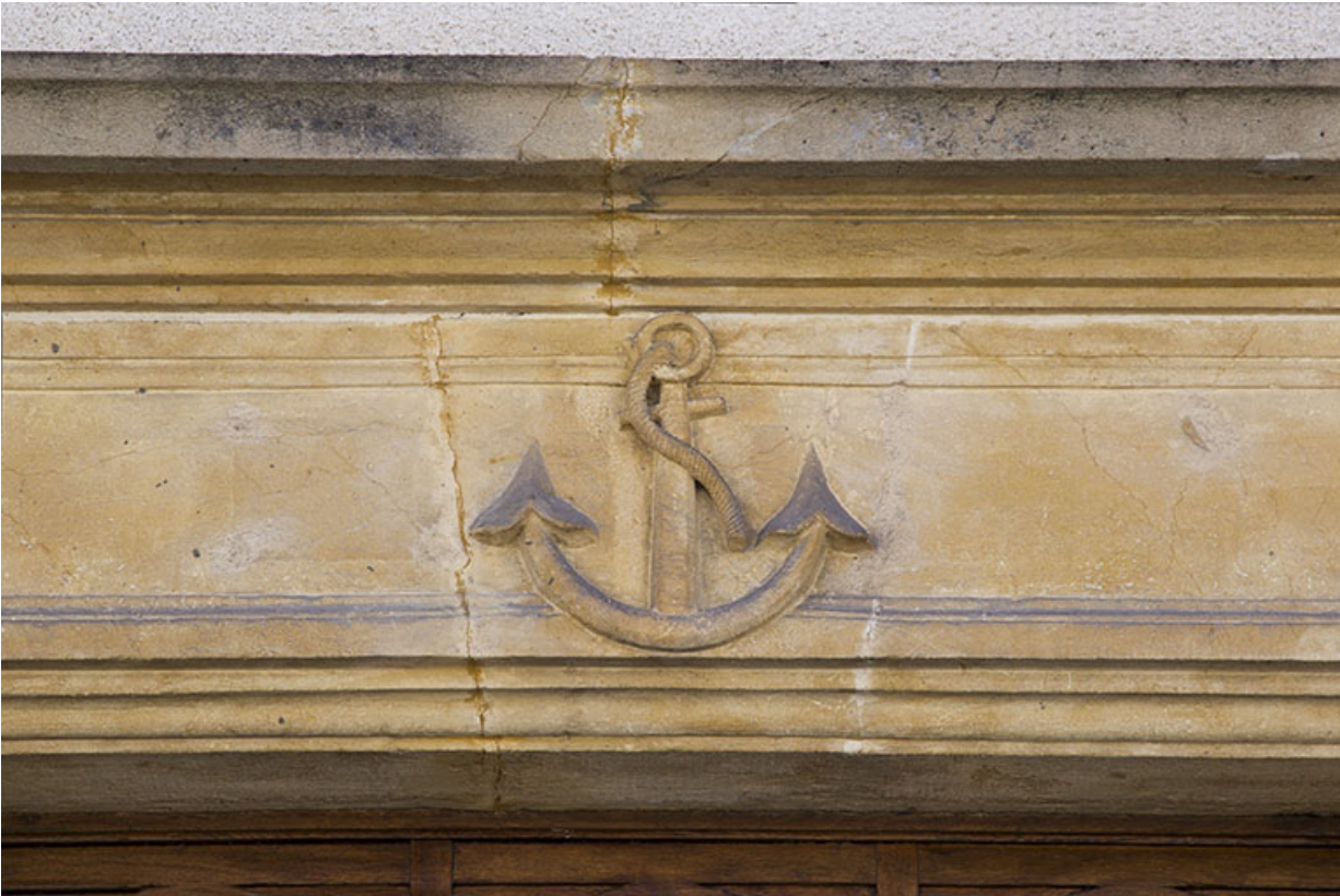
Ancre sculptée sur le linteau de l'entrée.
