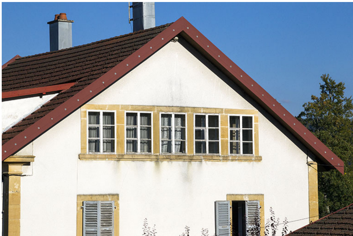
Pignon occidental : fenêtres multiples.
