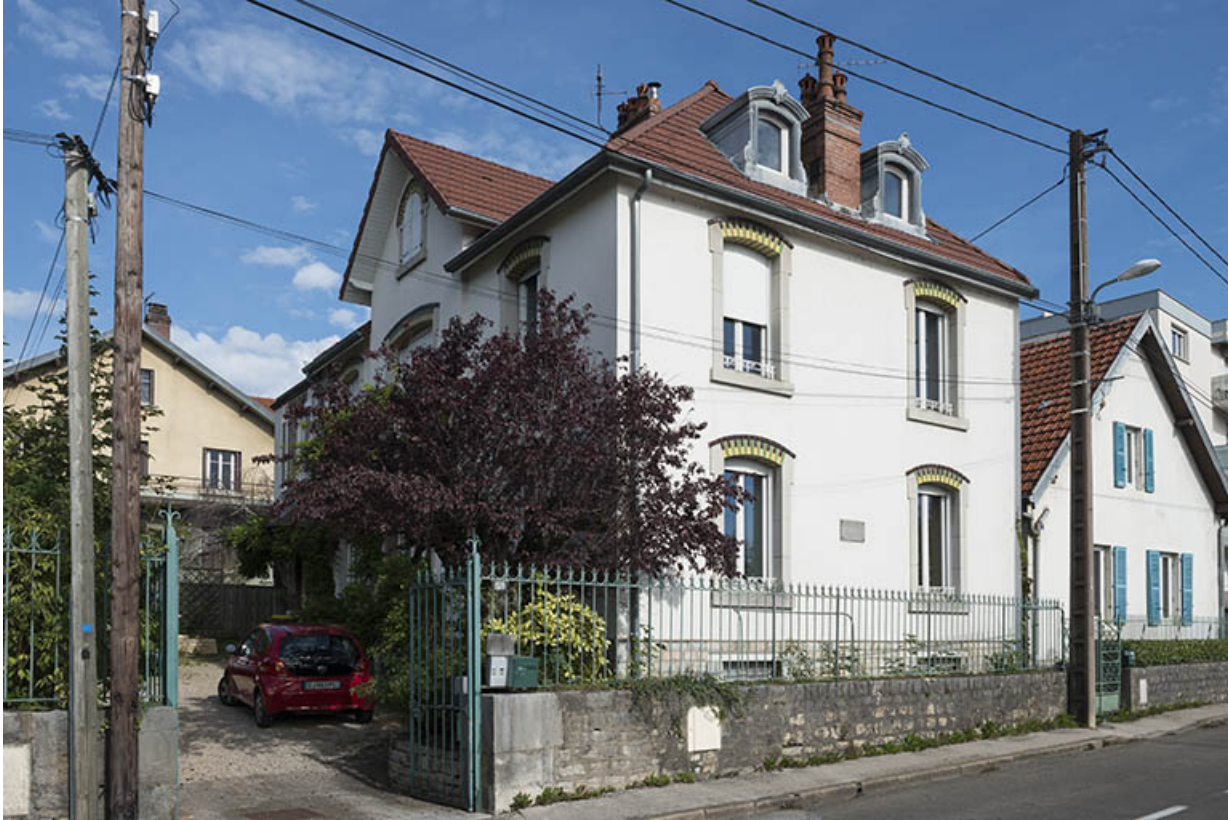
Vue de trois quarts depuis la rue.
