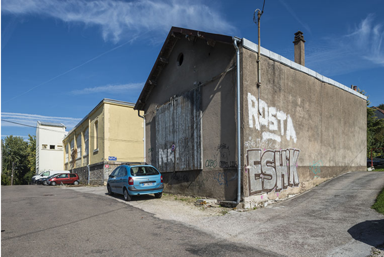
Façade ouest des ateliers.
